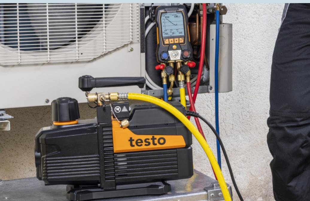
Válvula antirretorno para evitar la pérdida de vacío en caso de un corte en el suministro eléctrico
