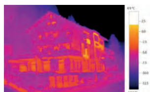
Imagen térmica con testo ScaleAssist
