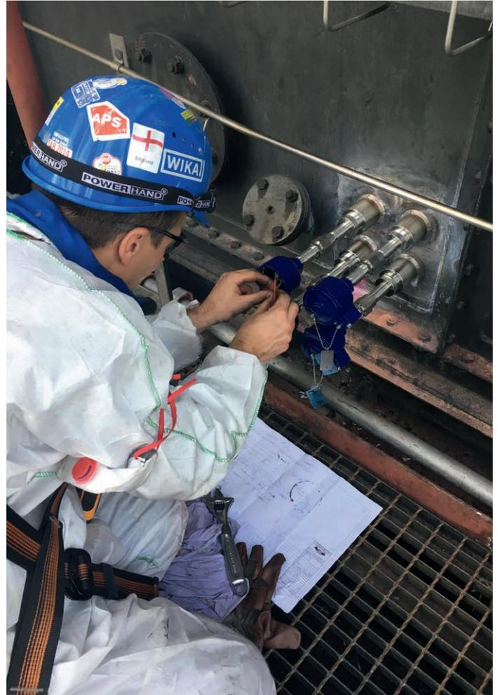
Transmisión de señales y prueba de funcionamiento
